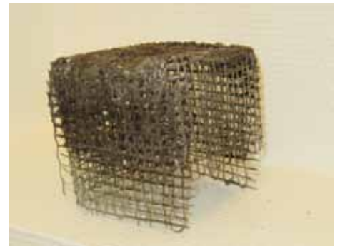
Åben udluftning der tidligere var sikret med resten
